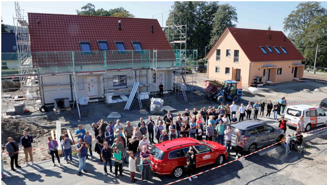
Blick auf zwei der Häuser im neuen Wohngebiet im Kamenzer Ortsteil Cunnersdorf, die fast fertig sind. © Matthias Schumann
