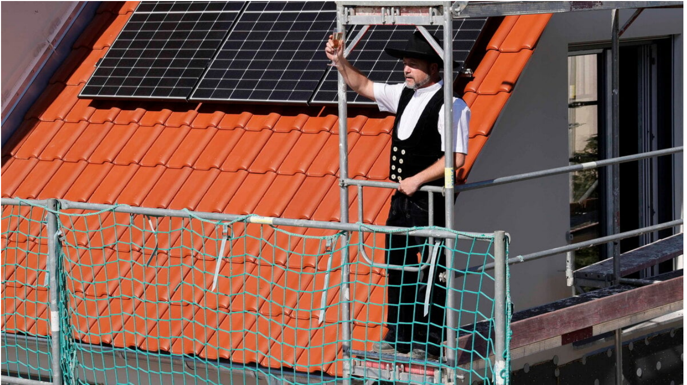
Bauleiter Thomas Uhl spricht den Richtspruch für eines der Häuser in der neuen Wohnsiedlung in Cunnersdorf. © Matthias Schumann
